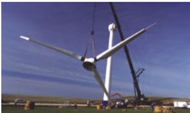
Levage d'un rotor dans le parc éolien de Widehem (Pas-de-Calais) La partie mobile en bout de pale permet d'arrêter la machine en cas de besoin (vent violent, visite de maintenance, etc.)
