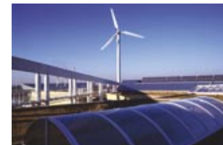
Une éolienne assure une partie de l'alimentation électrique d'un lycée à Calais
